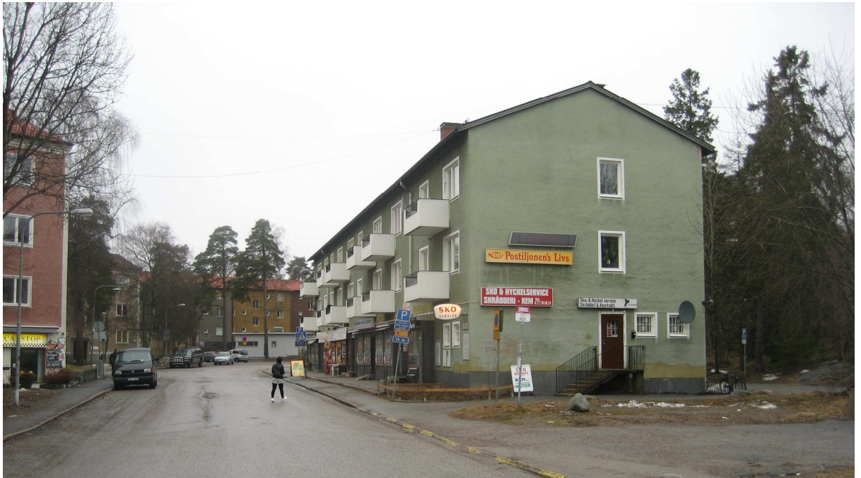
Centrumhus vid Postiljonsvägen
